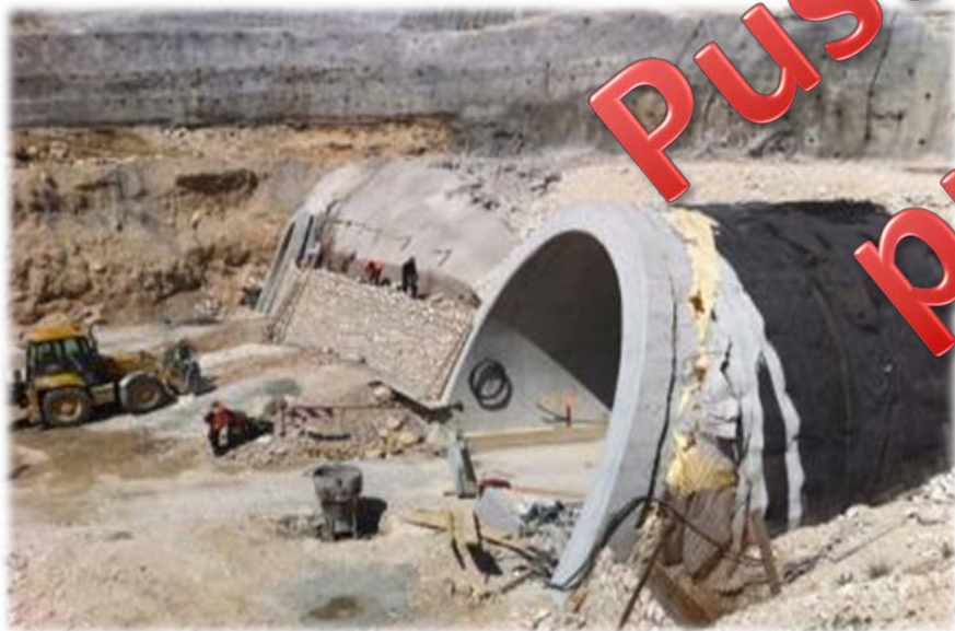
Stanje na gradilištu Q1 2013.
