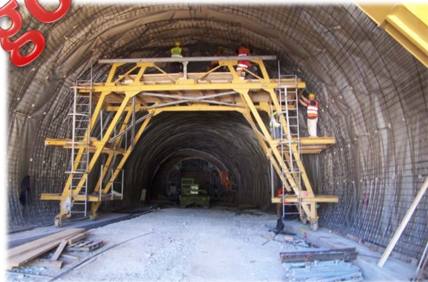
Stanje na gradilištu Q2 2013.
