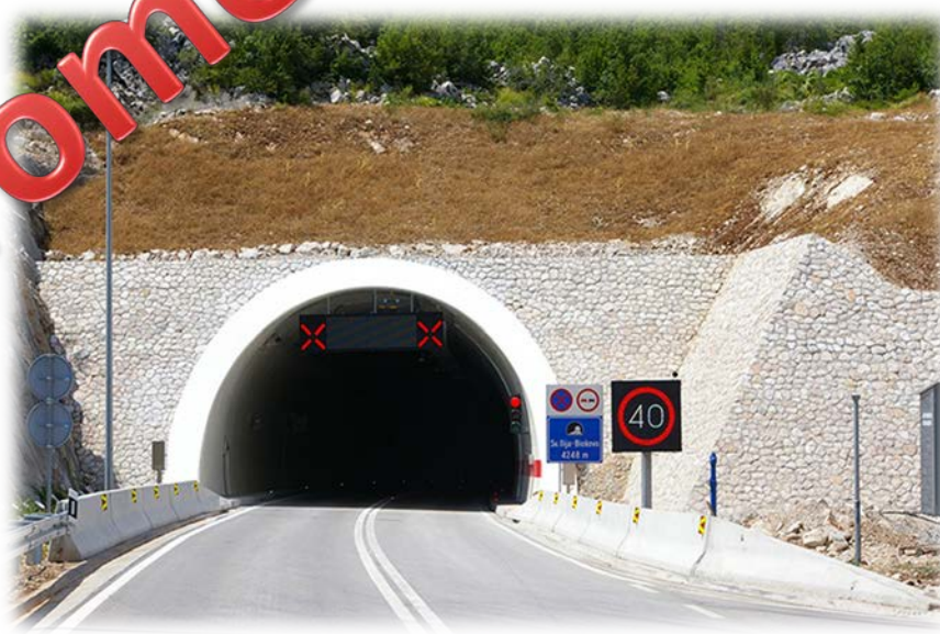
Stanje na gradilištu Q2 2013.
