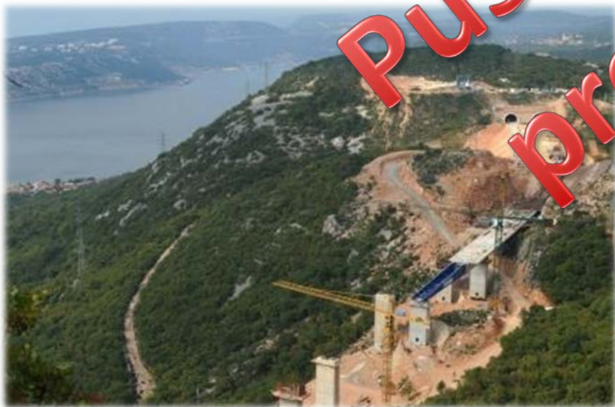
Stanje na gradilištu u 2012.
