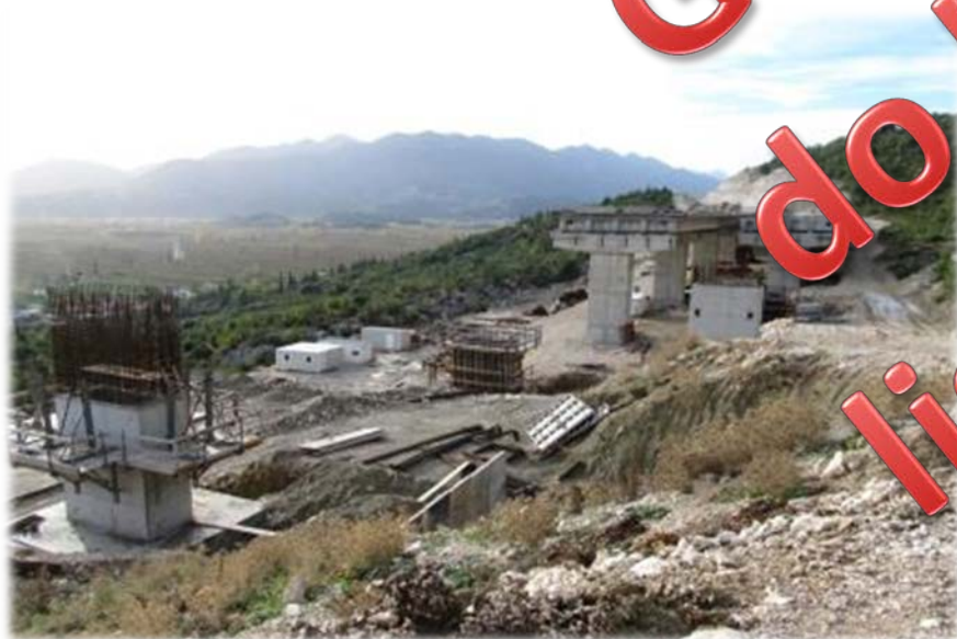
Stanje na gradilištu Q1 2013.
