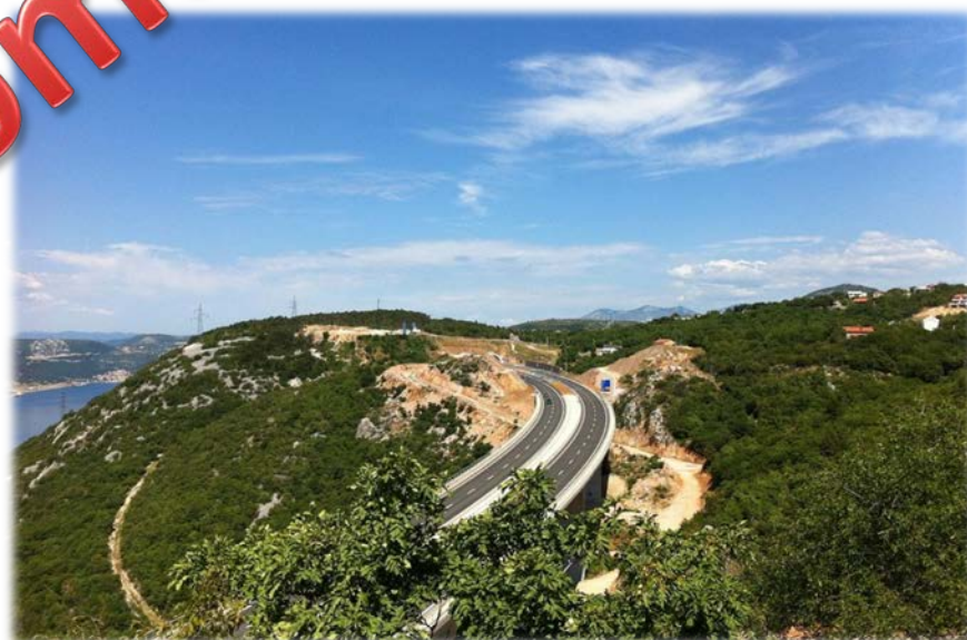
Stanje na gradilištu u 2013.
