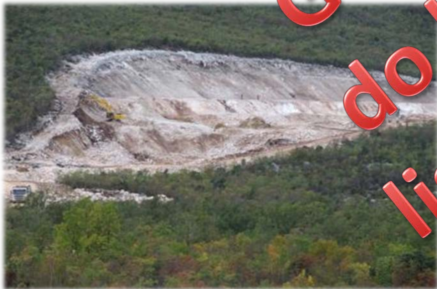
Stanje na gradilištu Q1 2013.
